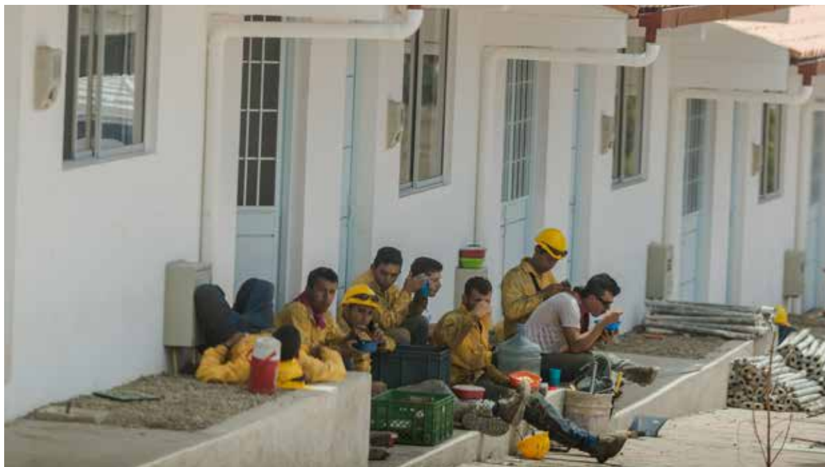
→ Operarios almorzando mientras retoman las labores de construcción del Nuevo Gramalote.
